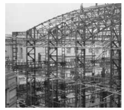
建設中の体育館 1963年
