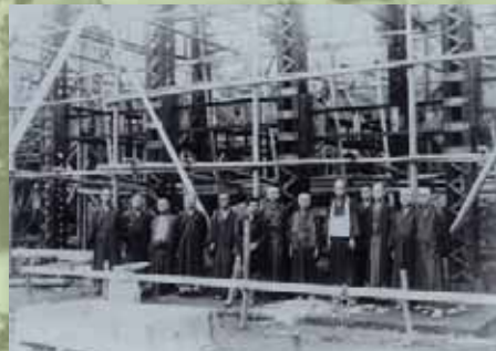
建築中の新図書館(耕雲館・現当館)
