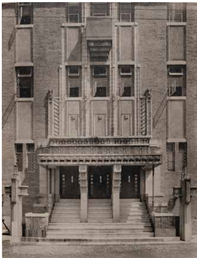
旧新橋演舞場外観 西側非常口付近
