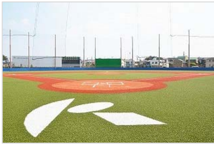
【竣工した祖師谷グラウンド】
